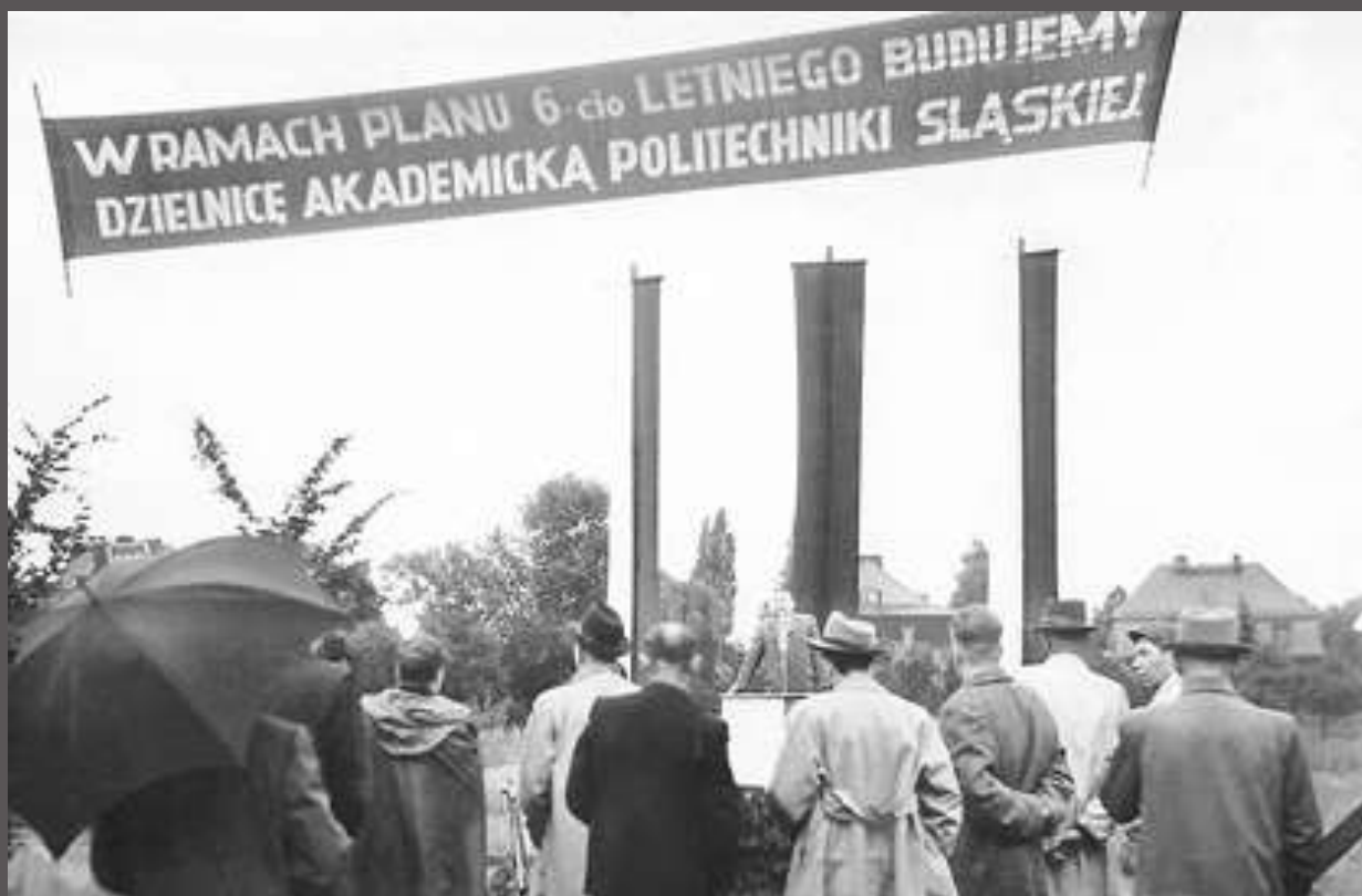
Budowa Dzielnicy Akademickiej
