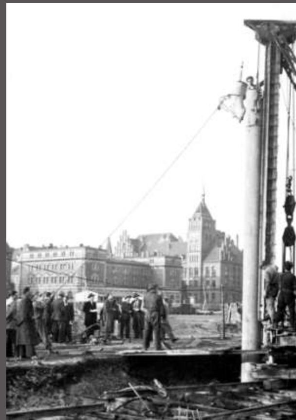
Budowa dzielnicy akademickiej w Gliwicach
