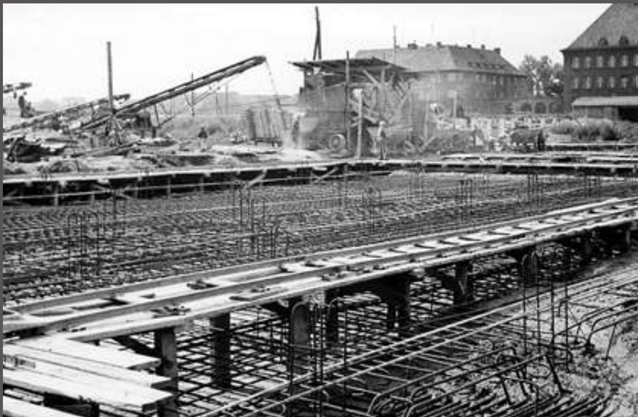
Budowa Wydziału Budownictwa
